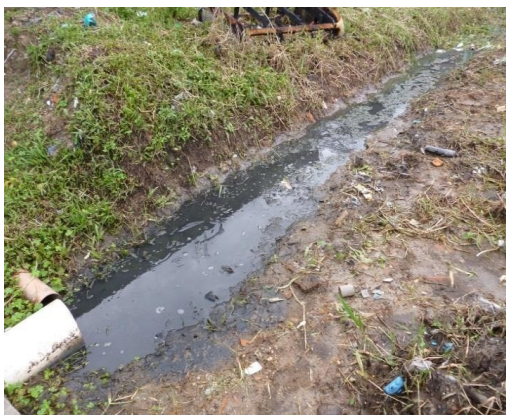
Foto 1: Alcantarilla a cielo abierto en el
